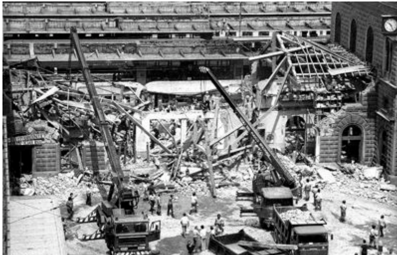
Las ruinas de la estación ferroviaria de Bolonia después del atentado perpetrado por los terroristas de la OTAN (1980).
