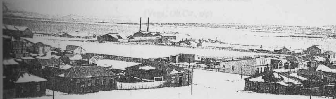
Panorámica de Puerto Natales nevado, c.1925. Al centro pueden verse las chimeneas del Frigorífico Natales; al fondo, la península A.Varas. (Fotografía E.Alarcón, en Benavides, et.al. Ob.Cit. , fig.20, p.50.)
