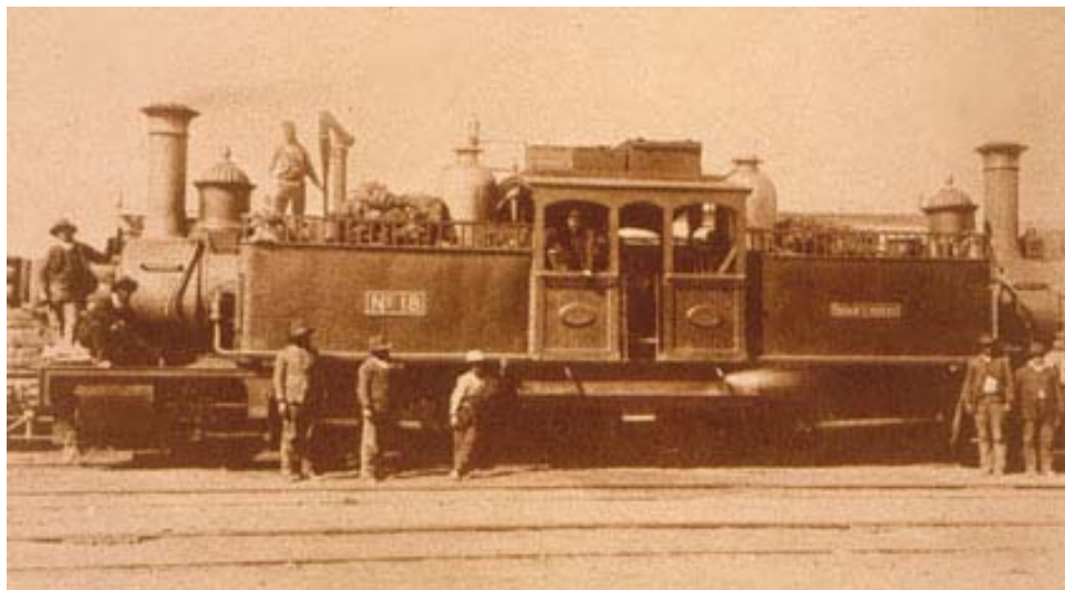
Locomotora No.18 de la "Nitrate Railways Co. Ltd" (Ferrocarriles Salitreros de Tarapacá), de modelo Fairlie doble, disposición de ruedas 0-6-0+0-6-0T, construida por la empresa inglesa "Avonside", de Bristol en 1873, número de serie del fabricante: 945.
