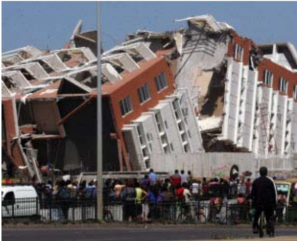
Los residentes observan el edificio que derribó el sismo en Concepción
