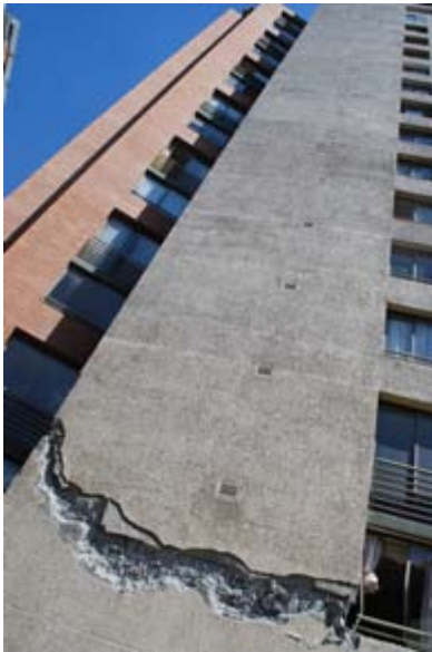
Edificio Central Park
