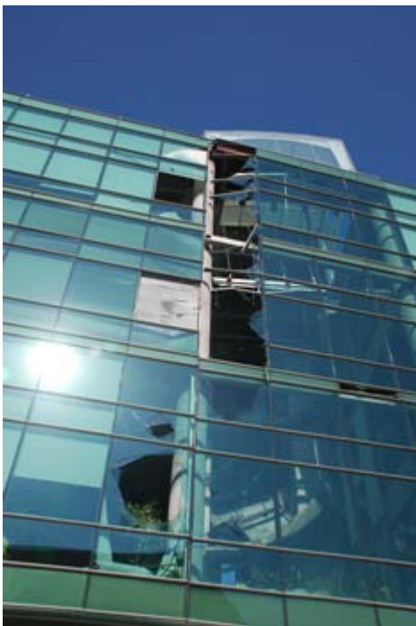
Edificio Patio Mayor 945
