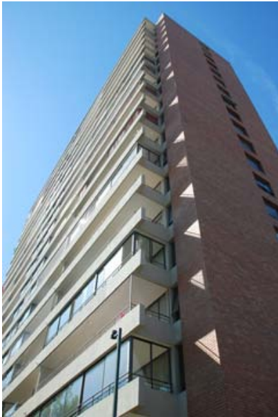
Edificio calle Rafael Prado
