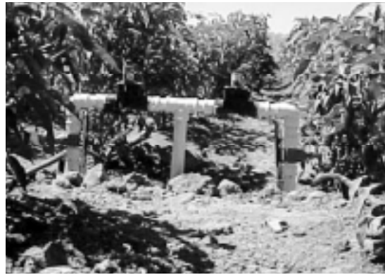
Instalaciones de bombeo
