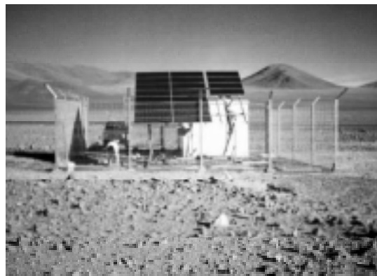
Instalación de Fibra Óptica. Norte de Chile
