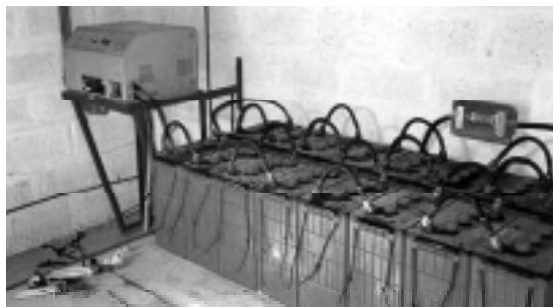
Banco de baterías, inversor, 48 V, c.c. / 220 V, c.a.
