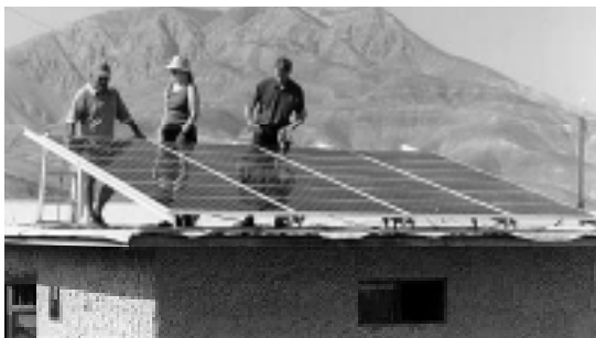
Generador solar, 1.5 kWp
