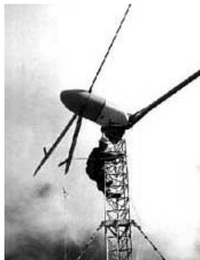
Servicios Eólicos: Máquina de 10 kilowatts
