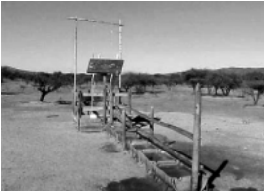
Instalaciones de bombeo
