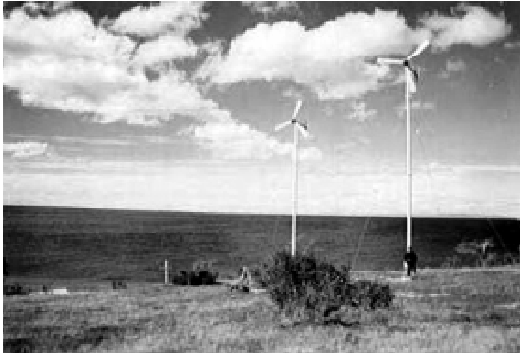
Agua Fresca (Km 25 Sur de Punta Arenas) 2 Bergey 1,5 Kw
