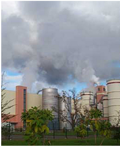
Planta de Celulosa de Celco, Valdivia .
